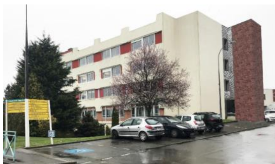
Aspect extérieur après phase 1
