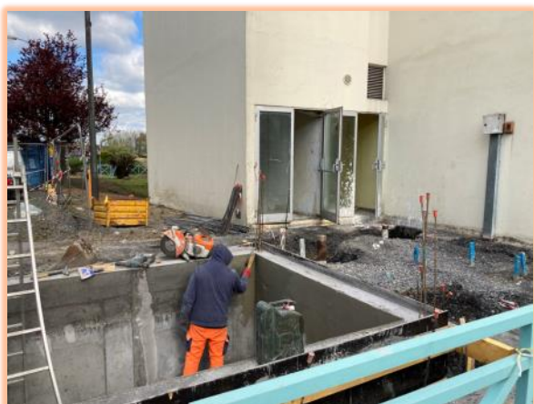
Fond de cuve, cage d'ascenseur extérieur
