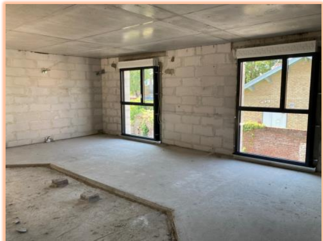
Pose de menuiseries extérieures
