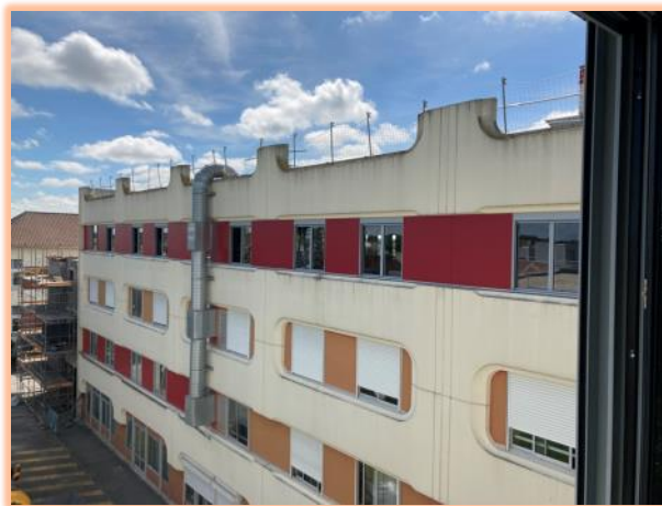
Isolants et panneaux TRESPA de façade, réfection complète de la toiture
